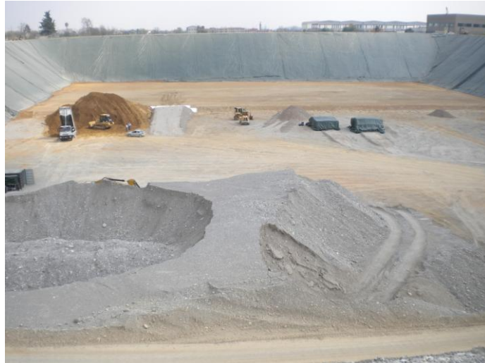
FIG. 4.2 Fase di costruzione della discarica è già possibile Individuare l'impermeabilizzazione delle pareti
