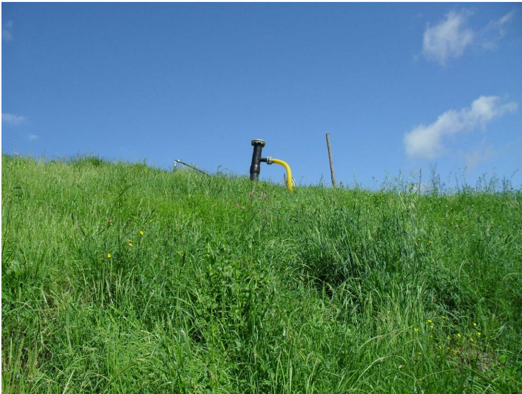
FIG. 4.6 Testa di pozzo e scarpata della discarica
